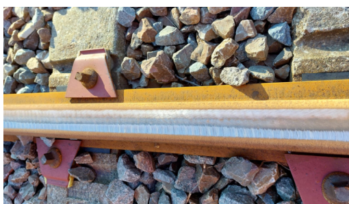
Illustration du rail oxydé APRES passage du camion
